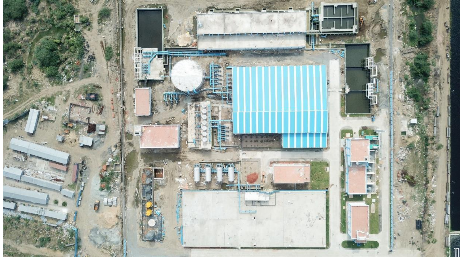
45 MLD TTRO PLANT, CHENNAI
