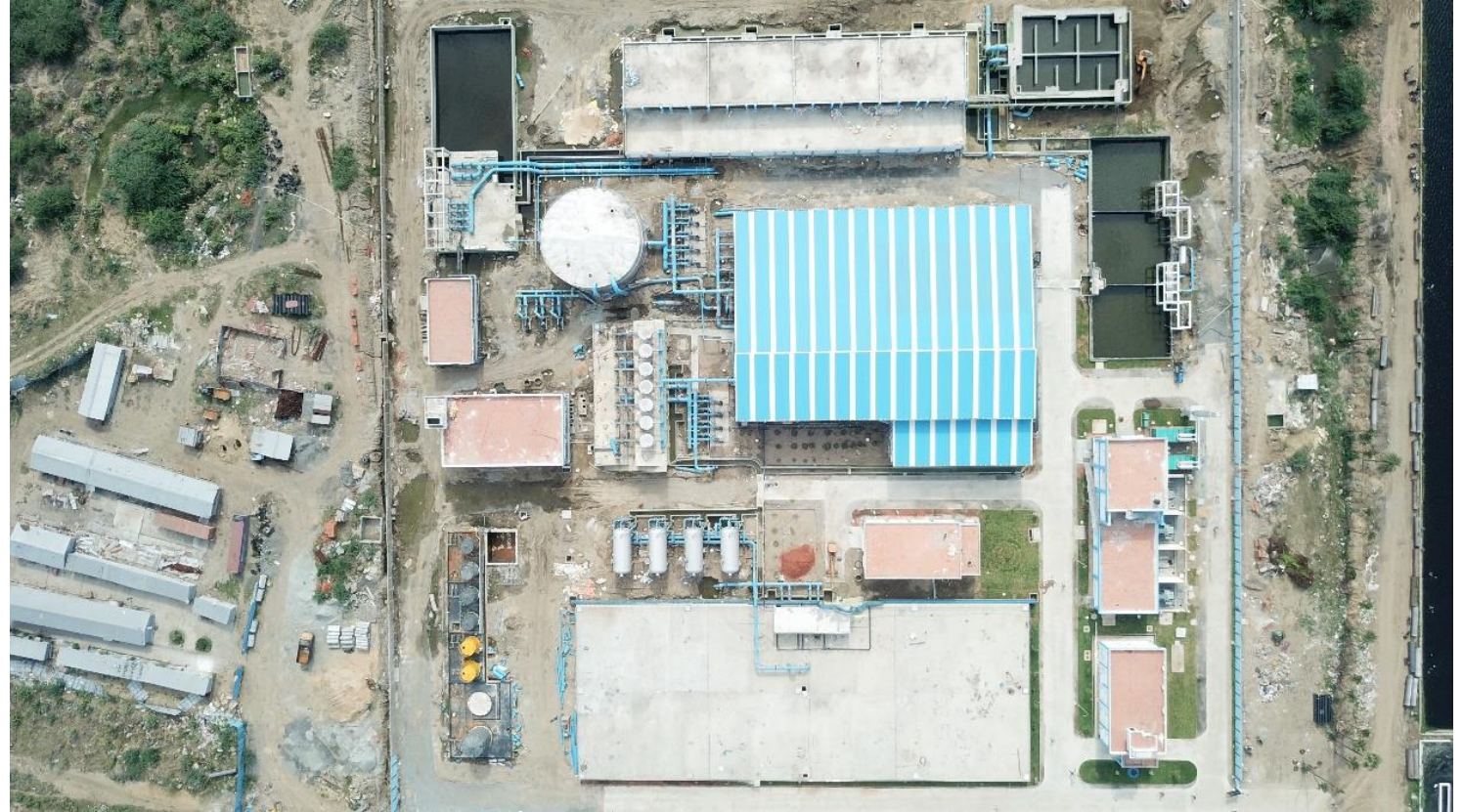
45 MLD TRO PLANT, CHENNAI
